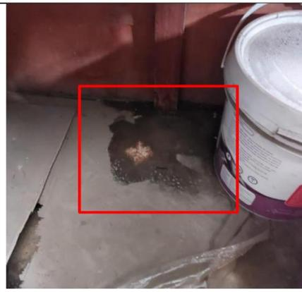
**Fuente:** Almacén presenta humedad en su ambiente del piso con humedad por filtración.
