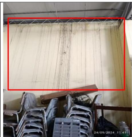
**Fuente:** Almacén presenta paredes con suciedad, a consecuencia del agua de lluvia que se filtra de las canaletas, lo cual puede generar humedad y consecuente el deterioro del material almacenado.
