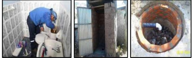
Reparación de cañería por fuga de agua      Letrina      Pozo de percolación expuesto al aire libre, sin tapa con riesgo de accidente
