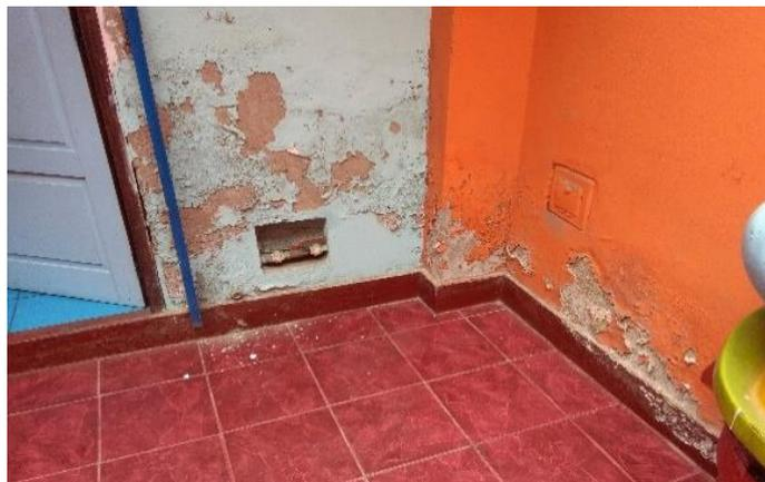
Foto 3: En este caso se aprecia que existe una fuga de agua provocando que la filtración se haya expandido por todo el muro, Se debe picar el muro siguiendo el recorrido de la tubería ya sea por muros o piso hasta encontrar el lugar de la fuga de agua.
